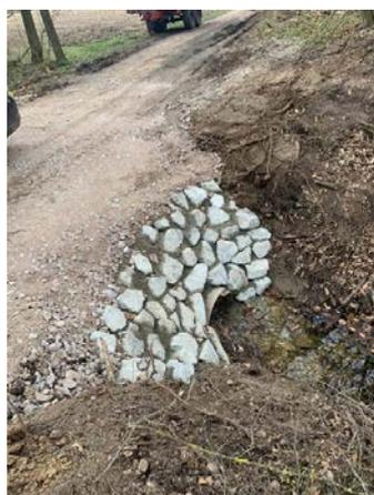
Der Betondurchlass des Auwiesengrabens unter der Zufahrt zum Auwald war zusammengebrochen und staute das Wasser in die Auwiesen zurück. Zudem sackte beim dorfsseitigen Auslass die Böschung ab. Deshalb wurde das Betonrohr durch ein Stahlrohr ersetzt und die Böschungen beim Rohr mit Granitsteinen befestigt.
