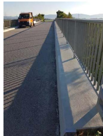
Im August wurde die Sanierung der Bahnbrücke durch eine beauftragte Fachfirma abgeschlossen. Die Betonkappen der Brücke wurden mit einer Schutzschicht überzogen und vorhandene Risse in den Widerlagern und Brückenkörpern mit Füllmaterial verpresst. Nebenarbeiten konnten durch unsere Bauhofmitarbeiter erledigt werden.
