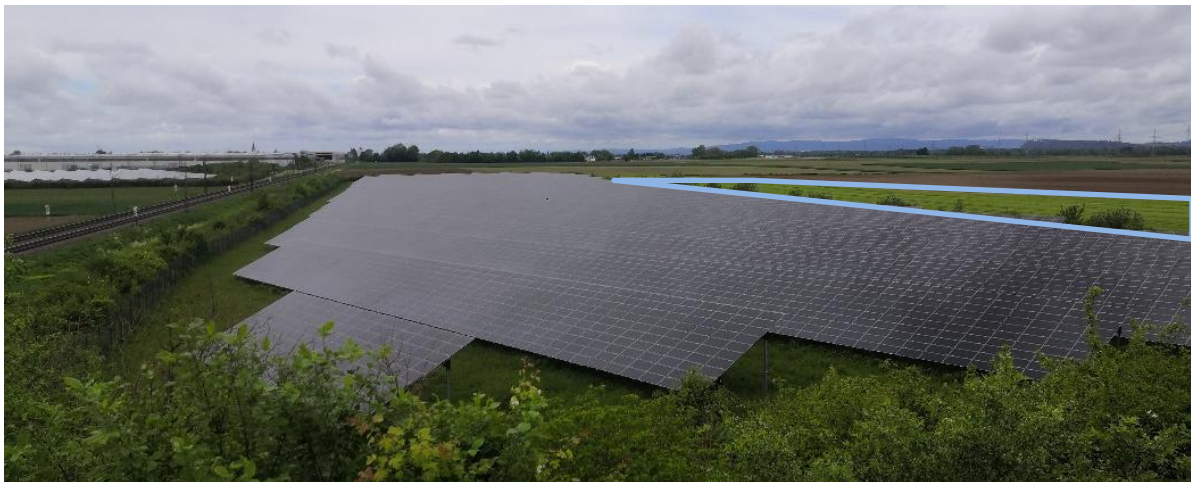
Blick von der Brücke über die Bahngleise (Bierweg) über Teilbereich II und Erweiterung durch Teilbereich III
