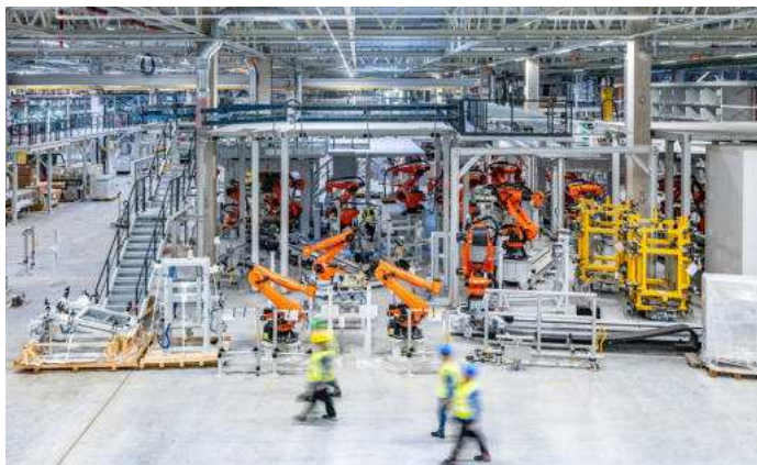
Anlagenaufbau BMW Straßkirchen
